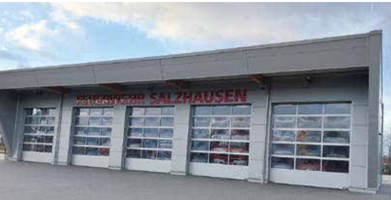
■ Feuerwehrhaus Salzhausen Witthöftsfelde.
