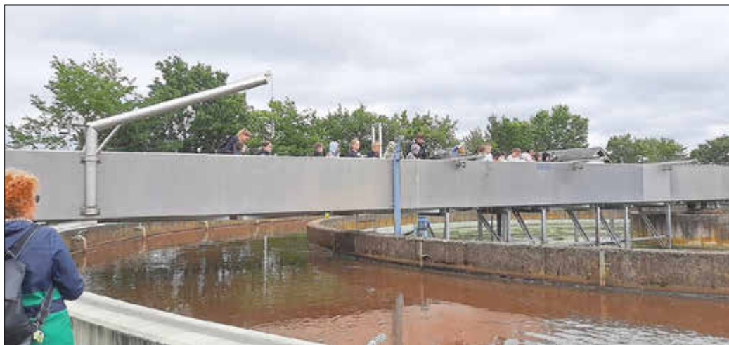
Besichtigung des Belebungsbeckens auf der Räumerrücke
