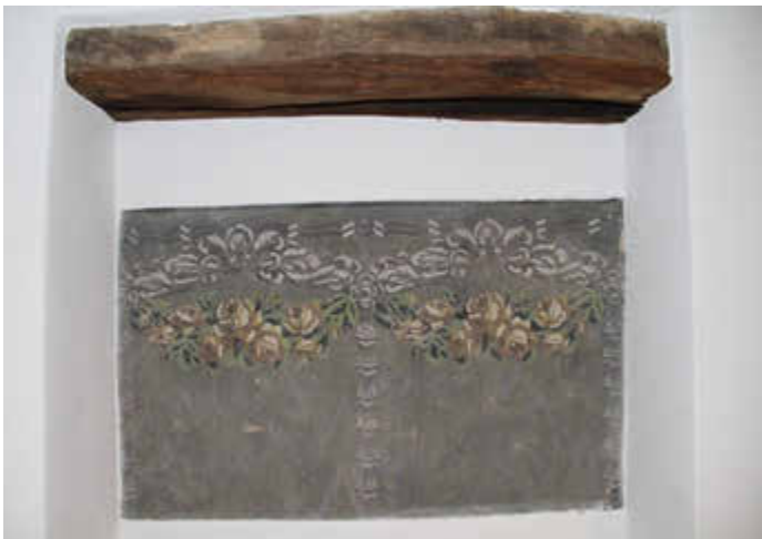
Foto oben: Wohnhaus vor Sanierung (Quelle: Wikipedia, Colling-Architektur, Lizenz: https://commons.wikimedia.org/wiki/Category:CC-BY-SA-3.0 ) Foto Mitte: Wohnhaus nach der Sanierung Foto unten: Nische mit Holzbalkensturz und historische Wandbemalung
