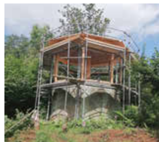
Holzaufbau neues Dach
