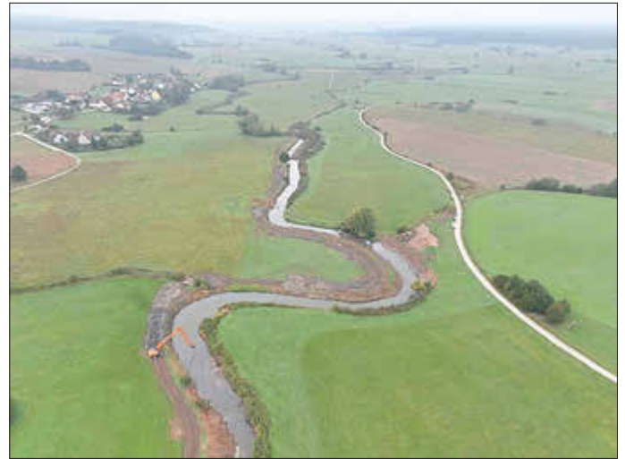
Drohnaufnahme vom 23.09.2024: Start zur Renaturierung der Oberen Altmühl zwischen Großenried und Thann
