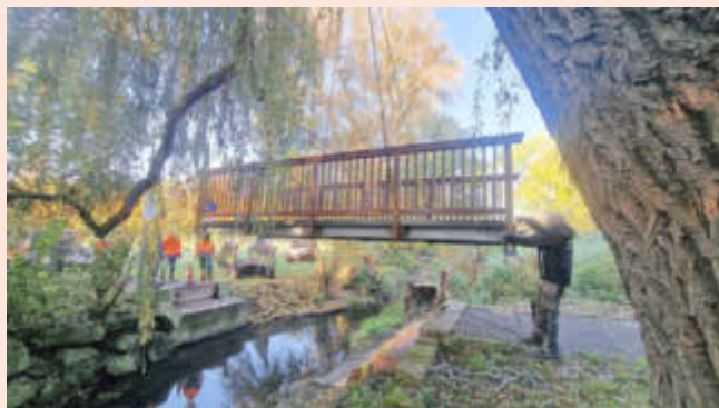
Mit einem Kran „schwebte“ die neue Brücke an ihren Platz.
