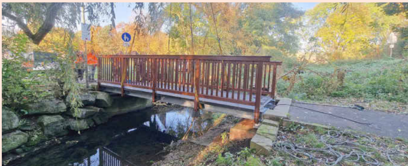
„Millimeterarbeit“ - die neue Brücke wurde perfekt eingepasst.
