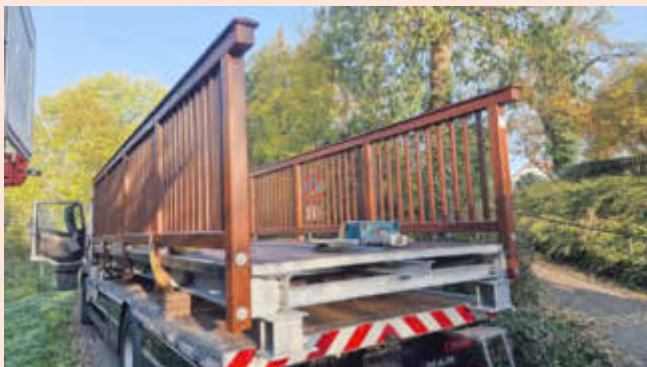
Die neue Brücke wurde bereits vormontiert angeliefert.
