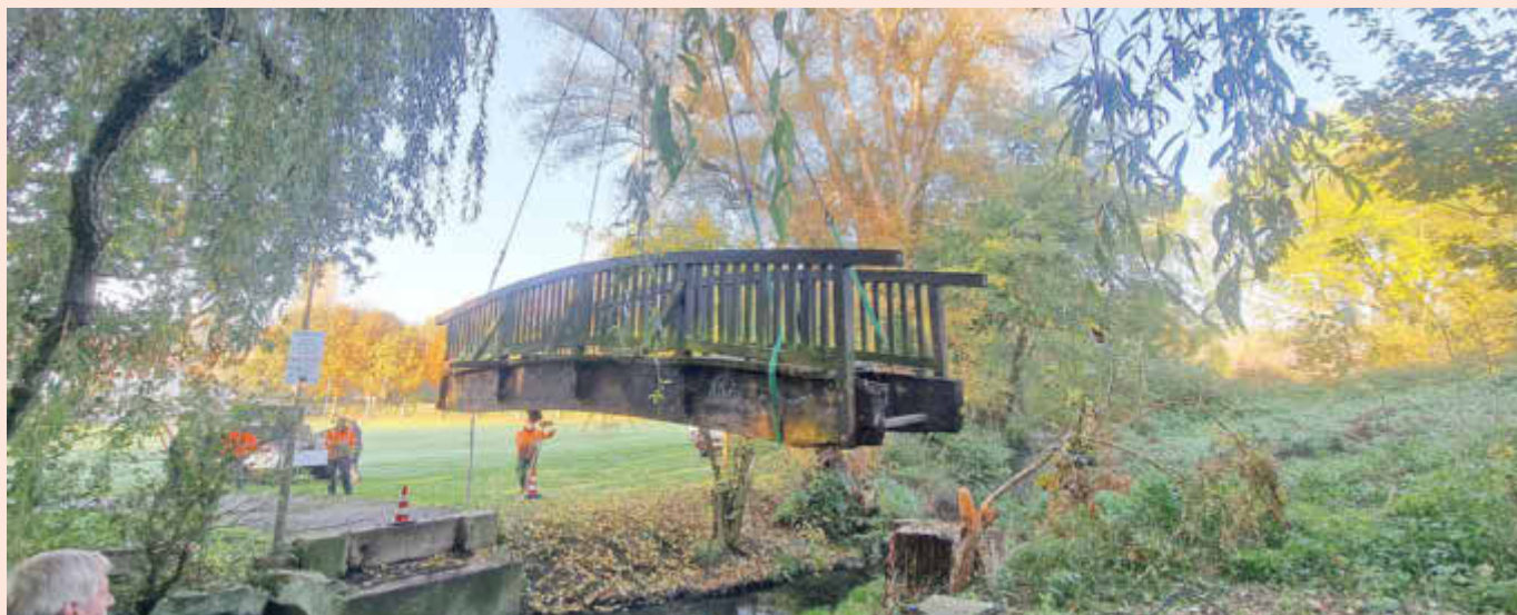
Seit 1971 war die alte Brücke am Mühlenberg „im Einsatz“.
