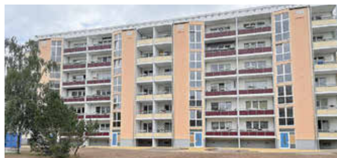
Wohnanlage Hamburger Ring 9–12 nach dem Bau des Liftschachtes Foto: AWG
