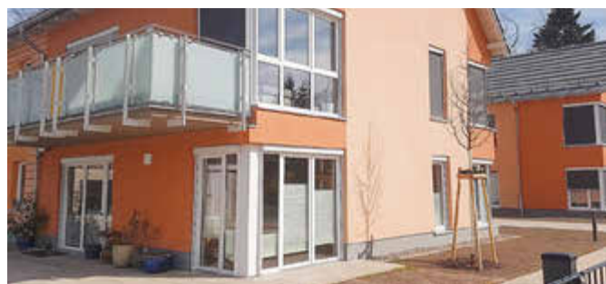
Neue Wohnanlage „Am Bock“
