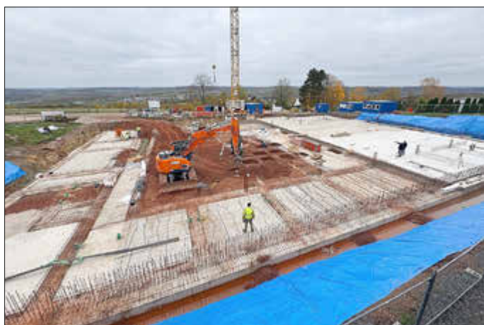
Die Bauarbeiten sind bereits in vollem Gange
