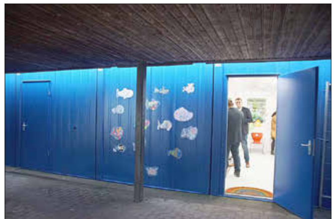
Blick auf die Container, die sich direkt an die Pausenhalle anschließen
