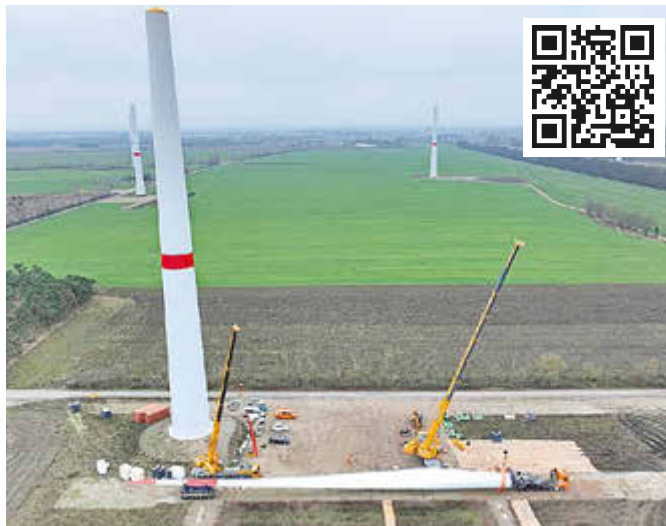
Die Großkomponenten erreichen die Baustelle
