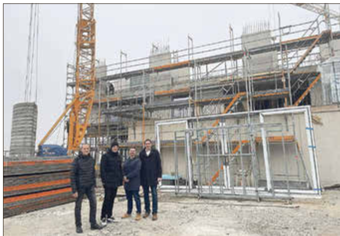
Auf der Baustelle: Außen noch Rohbau, während im EG bereits der Innenausbau startet. V.l. Bauherren Sebastian & Florian Behrend, Gastronom Willi Wimmer und Übersees Bgm Herbert Strauch Foto: Ökomodell Achantal
