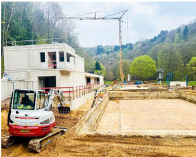
Bürgermeisterin Janine Fischer mit den Verantwortlichen auf der Baustelle des Freibads. vorne v. li.: Bodo Schulz (Geschäftsführer Fa. Dillig), Daniel Martin (Polier Fa. Dillig), Karsten Schellenberg (Protec Ingenieure); hinten v. li.: Philipp Francois (VG Bitburger Land), André Freres (VG Bitburger Land), Josef Hilden (VG Bitburger Land.) Peter Spitzner (Protec Ingenieure). Foto: VG Bitburger Land
