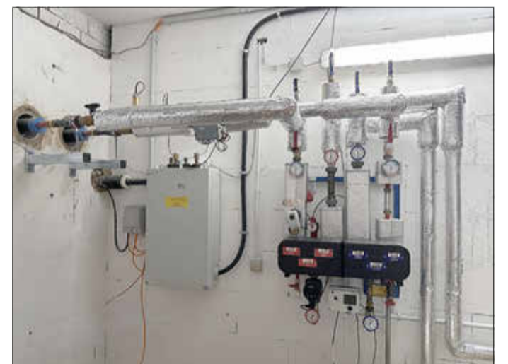
So in etwa sieht die Übergabestation aus, die dann die Funktion der bestehenden Heizanlage – wie etwa ein Heizkessel oder die Gastherme – übernimmt.
