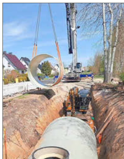
Foto: Ingenieur-, Tief- & Straßenbau Naumburg GmbH
