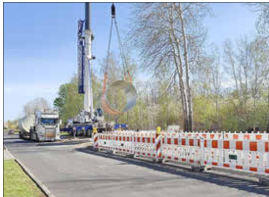
Foto: Ingenieur-, Tief- & Straßenbau Naumburg GmbH
