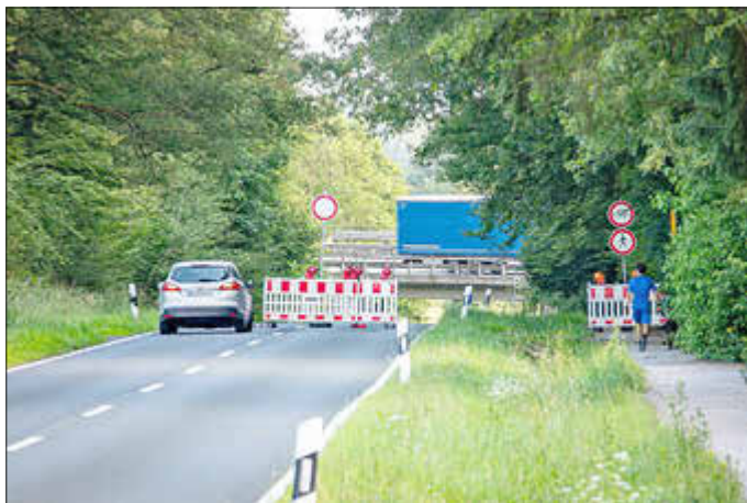
Absperrung: Aufgrund von Bauarbeiten an einer A3-Brücke gibt es seit Montag kein Durchkommen mehr auf der L317 zwischen Nentershausen und Eppenrod für Autofahrer, Fußgänger & Co. Fotos: Andreas Egenolf
