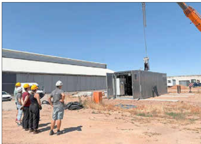
Bild: GP JOULE Renergiewerke Fuhne. Anlieferung der Heizzentrale am Standort in Quellendorf.
