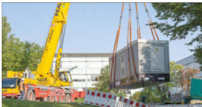
Kurz vor Ende der Ferien wurde die neue Trafostation im Schulzentrum Montabaur angeliefert.
