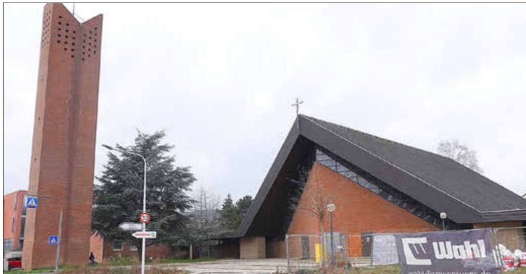
Werden abgerissen: Kirchenraum, Glockenturm und Pfarrhaus (verdeckt) von St. Pius. Foto: Weber
