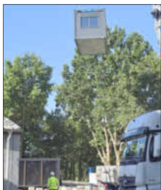
Ein großer Kran platzierte 60 Container-Module auf den Millimeter genau
