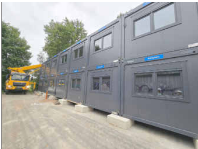
Die mobilen Räume wurden zweistöckig neben der Sporthalle auf dem Parkplatz aufgebaut
