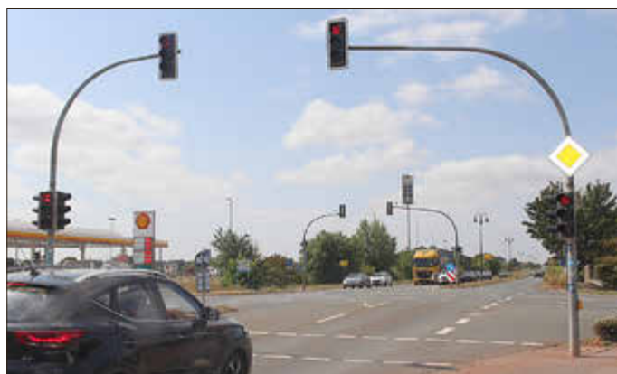
In einem der späteren Bauabschnitte wird auch die Kreuzung L47/ Berliner Allee in Hohenwarsleben grundhaft erneuert.
