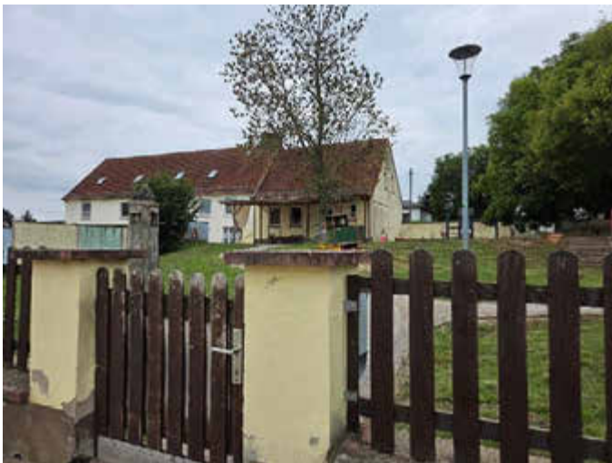
Blick von Toreingang Richtung Gebäude
