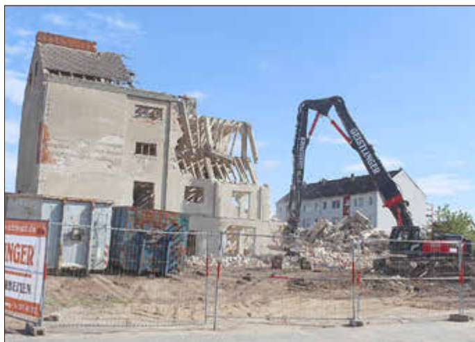
Mit schwerer Technik wurde der alte Speicher Stück für Stück abgetragen.
