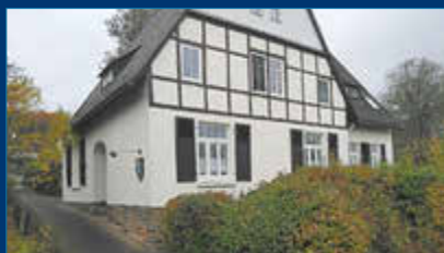
Fensterläden und -bänke am DGH in Kemmenau strahlen in neuem Glanz
