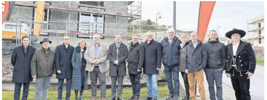
Beim Richtfest präsentierten die Beteiligten die Mehrfamilienhäuser, die für Nachhaltigkeit und soziale Aspekte stehen.
