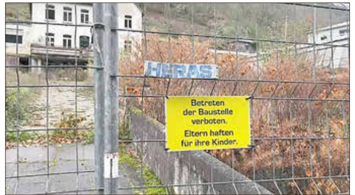
Hier soll es nach hoffentlich erfolgreichen Submissionsergebnissen losgehen: Baureifmachung am Grundstück für den Neubau der Feuerwehr St. Goarshausen in der Nastätter Straße.
