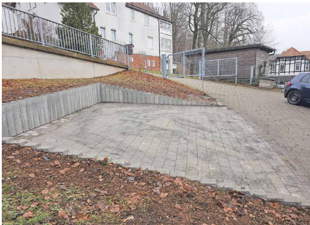
Durch die Schaffung von zusätzlichen Stellflächen hat sich die Parksituation am Schullandheim spürbar verbessert.
