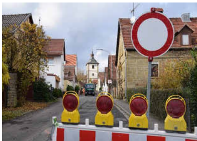
Im Rahmen der Dorferneuerung Obbach hat die Sanierung der Straßen Dorfgraben (Bild) und Am Heimbach im Herbst begonnen.
