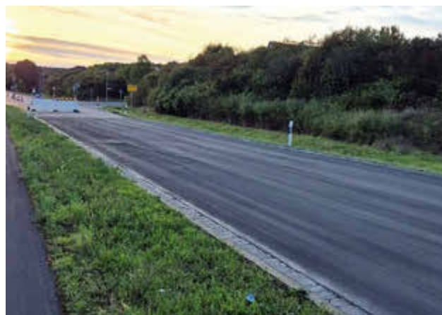
Saniert wurde die Fahrbahndecke der B 303 zwischen Sömmersdorf und Euerbach.
