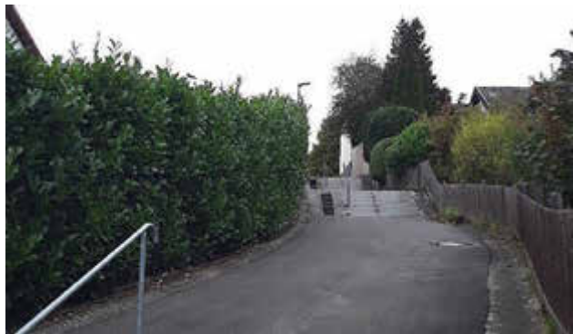
Eine neue Decke und neue Treppenstufen erhielt der mittlere Zauserweg in Euerbach.
