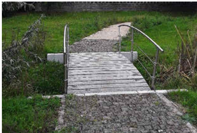
Ein Gemeinschaftsprojekt des Gemeindebauhofs und der Auszubildenden des Landkreises war der Verbindungsweg zur B 303 in Sömmersdorf.
