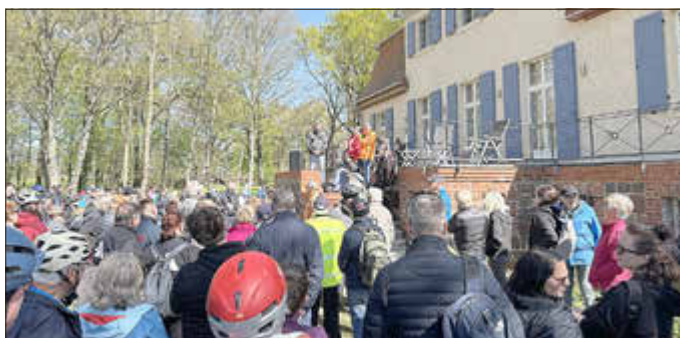
Am Rittergut Kemmen informierten die Betreiber über die umfangreichen Sanierungsarbeiten der letzten Jahre. Foto: Landkreis OSL / Nora Bielitz
