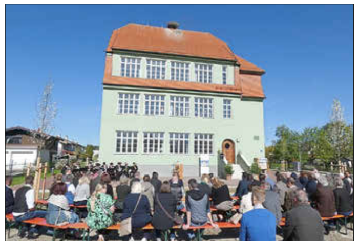
Im Beisein zahlreicher geladener Gäste wurde das aufwendig sanierte und revitalisierte alte Erlstätter Schulhaus am vergangenen Freitag bei Bilderbuchwetter offiziell eingeweiht und seinen vielfältigen Bestimmungen übergeben. Im Gebäude sind bereits das Pfarramt, einige Ortsvereine, die Jugend und die Eltern-Kind-Gruppe (EKP) untergekommen.
