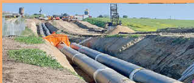
Die Arbeiten an der Fernwärmetrasse zwischen Leuna und Leipzig gehen voran; das Foto zeigt die verlegten Kunststoffmantelrohre östlich des Kalmusteiches mit Blickrichtung zum alten Wasserturm...
