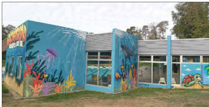
Betonwände im "neuen Gewand"
