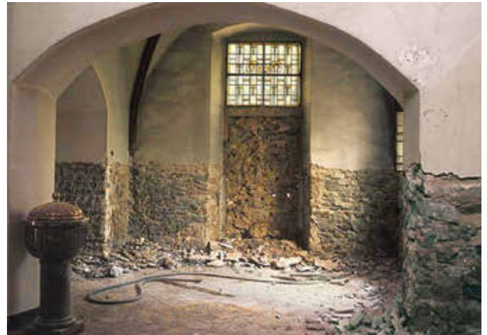
Taufkapelle vor der Renovierung
