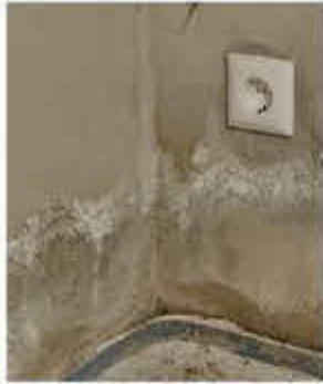
defekte Horizontalsperre
