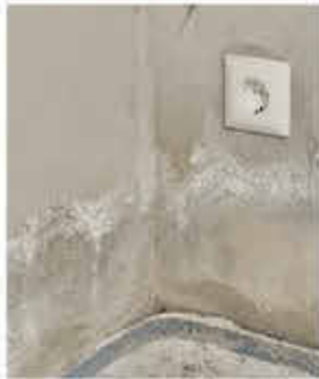
defekte Horizontalsperre
