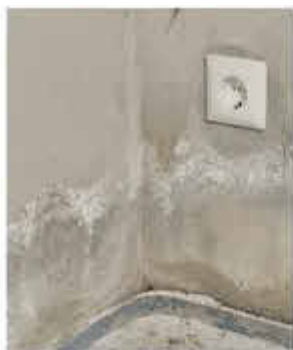
defekte Horizontalsperre
