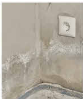
defekte Horizontalsperre
