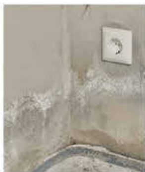
defekte Horizontalsperre
