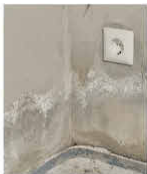
defekte Horizontalsperre
