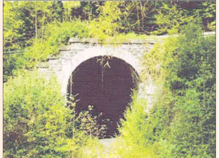
Nördliche Ausfahrt des Kirbergtunnels (Foto: Ronald Horn)
