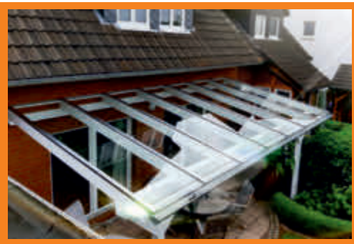
Neubau einer Terrassenüberdachung mit Eindeckung aus VSG Glas.
