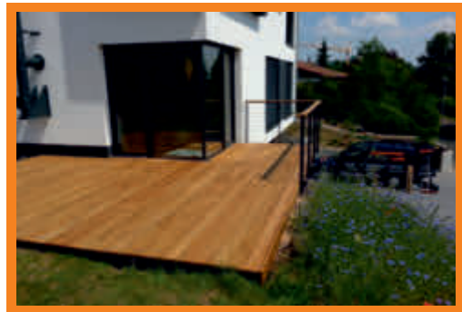
Neubau einer Terrasse mit Eichenholz auf einer maßgefertigten Unterkonstruktion aus verzinktem Stahl.
