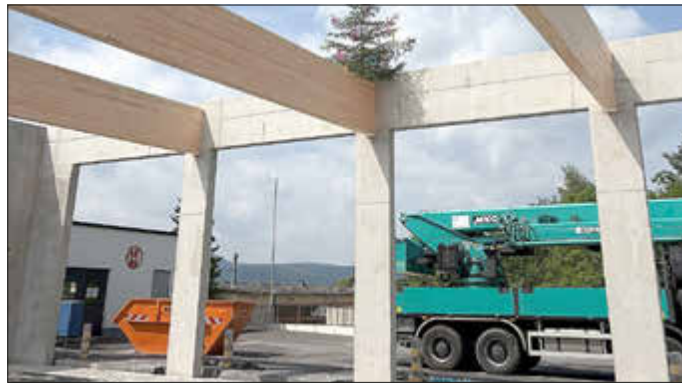
Die Binder liegen auf. Nun kann der Wiederaufbau weitergehen.
