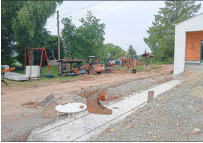
Blick auf die bereits errichteten Fundamente und die dahinterliegenden Rohrgräben für die Entwässerung.
