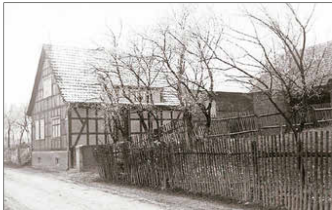
Wohnhaus Schloßstraße Nr. 1, um 1935
