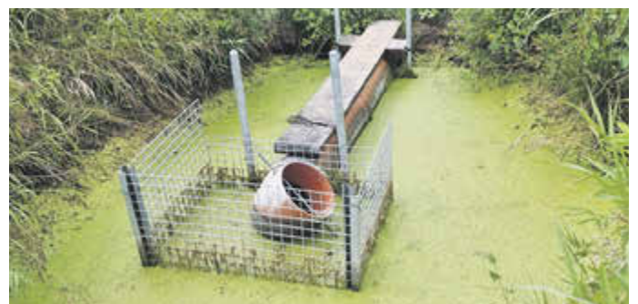
Biberdammdrainage (Foto: Landratsamt Wartburgkreis)
