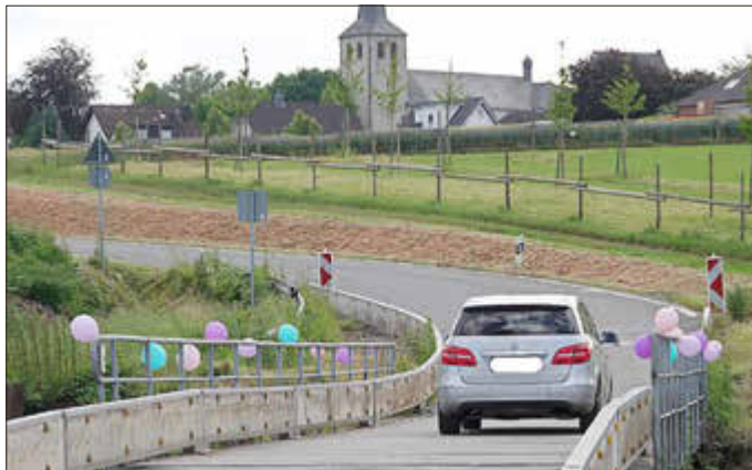
Sarkasmus pur: Zehn Jahre nach dem Bruch der Brücke wurde das Provisorium mit Luftballons bunt geschmückt. Fotos: Weber
