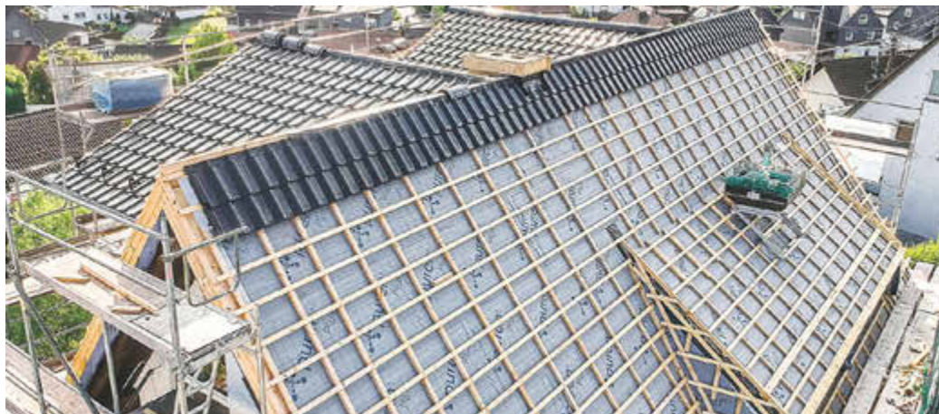
Bei einer energetischen Modernisierung oder Dachsanierung sollte der sommerliche Hitzeschutz mit beachtet werden. Foto: DJD/puren
