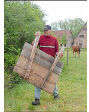
Abb. 2: Beim Steckschütz wird eine Holzplatte (Schütz) von Hand in einen fest oder temporär im Graben verankerten Rahmen eingesetzt – ein System, das, abhängig von der verfügbaren Wassermenge, immer angepasst werden muss.
