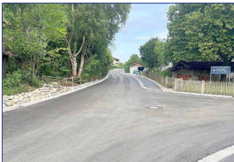
Die Bauarbeiten in der Wolkenberger Straße sind abgeschlossen
