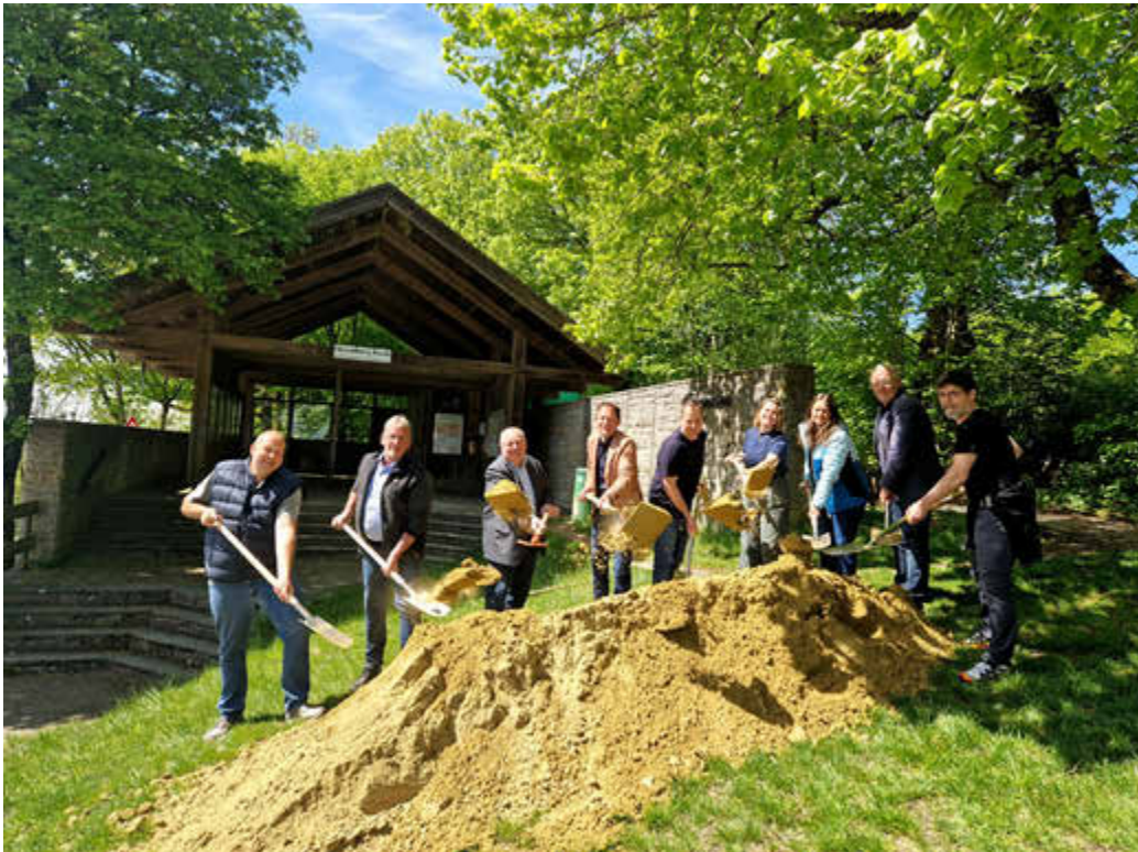
Erst im April 2025 erfolgte der Spatenstich durch die Verantwortlichen
