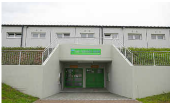
Das neue Umkleidegebäude ist in einer modernen Modulbauweise entstanden.
