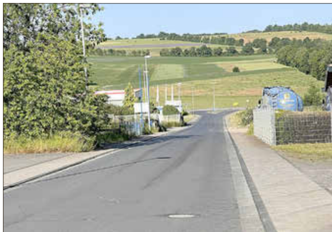
Die Zufahrt „In der Struth“ zum Gewerbegebiet wird noch in diesem Jahr saniert.
