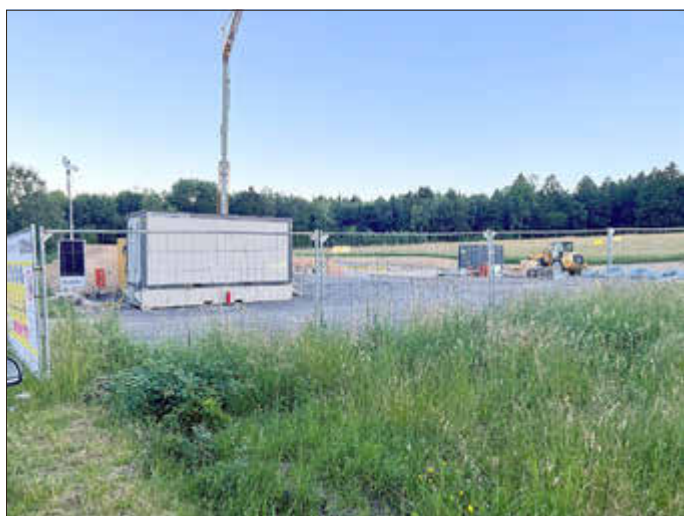
Im Bau ist das Umspannwerk am Westrand des Gewerbegebietes.
