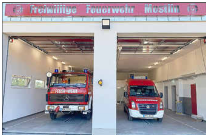
Blick in die neue Fahrzeughalle der Freiwilligen Feuerwehr Mestlin. Foto: M. Redelstorf
