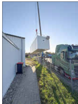
Errichtung der Raummodulanlage als Sozialtrakt
