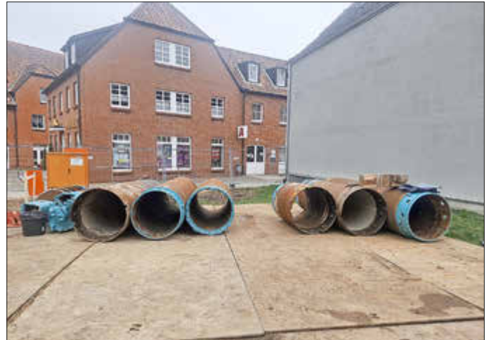
Diese Rohre werden im Erdboden versenkt Fotos: Stadt Wittenburg
