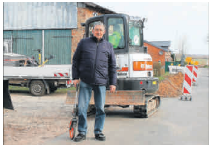
Breitbandausbau Bauaufsicht durch den Bürgermeister
